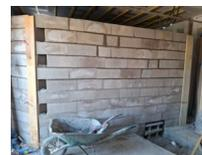
Le montage de la structure du silo à plaquettes forestières pour l'alimentation de la chaudière biomasse est en cours.
